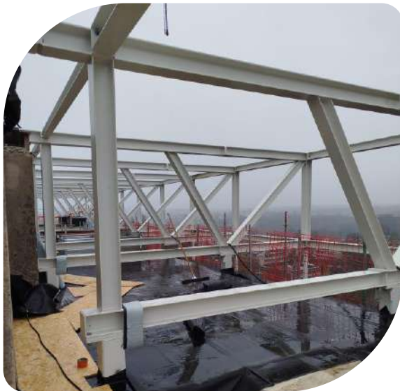
Nouvelle structure métallique placée et mise en tension réussie !
