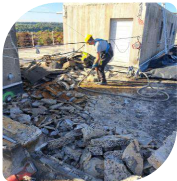
Bruit de démolition
