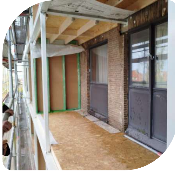
Extension des chambres Depuis l'extérieur
