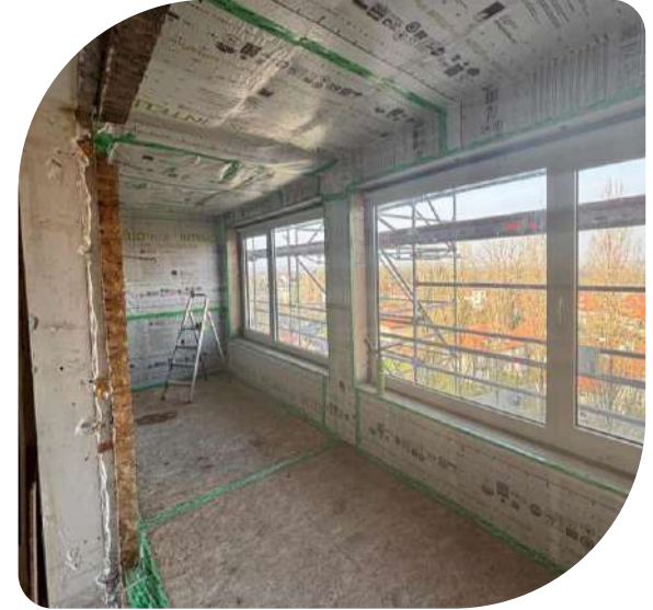
Extension des chambres Depuis l'intérieur
