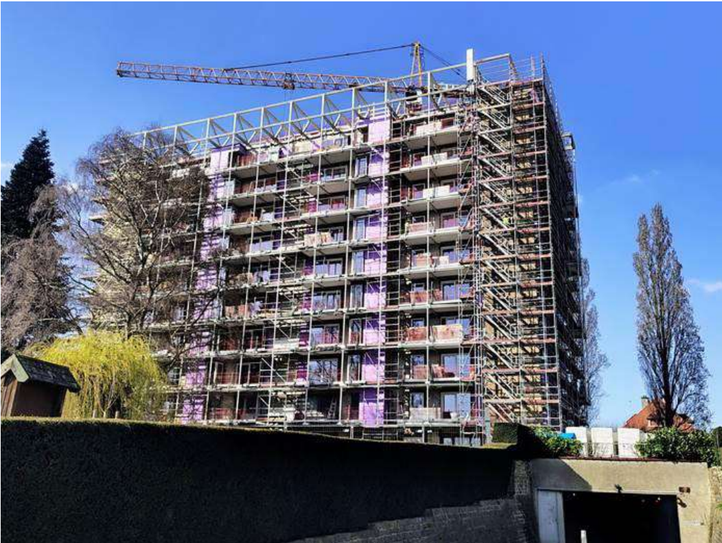
Foto 2 Aartshertogen 1 na asbestverwijdering
