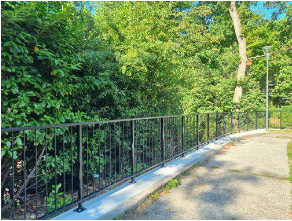
Nieuwe balustrade Bosnimfen
