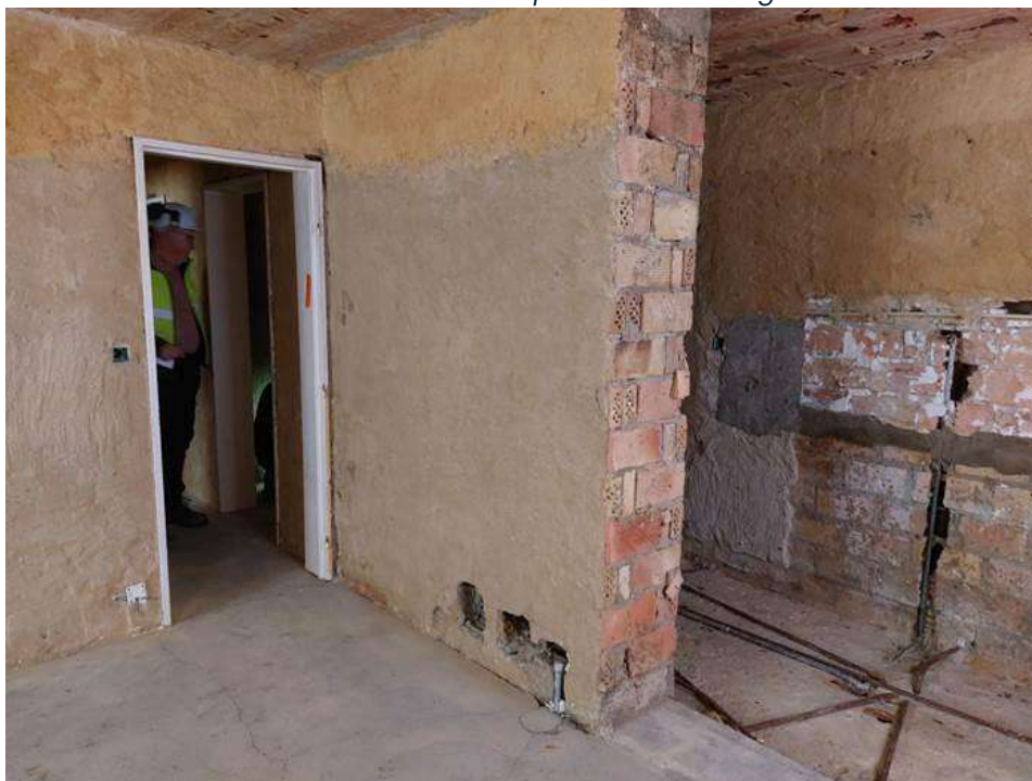
Photo 2 Archiducs 1 après désamiantage
