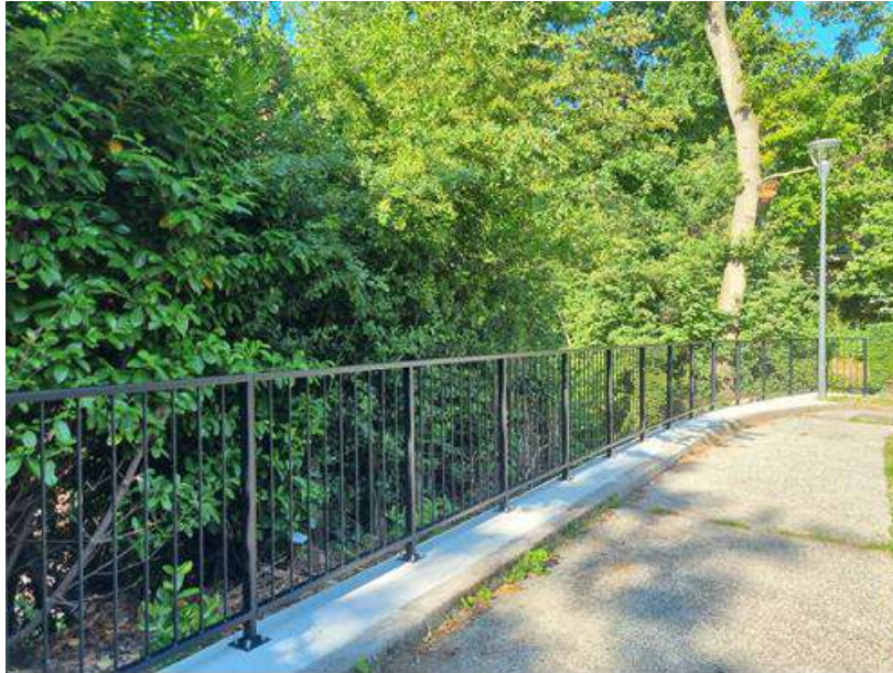
Sécurisation casquettes en béton Wauters
