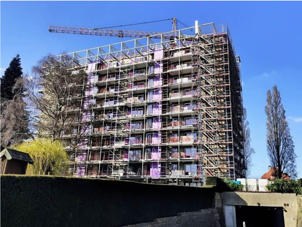
Foto 2 Aartshertogen 1 na asbestverwijdering
