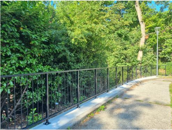
Nieuwe balustrade Bosnimfen
