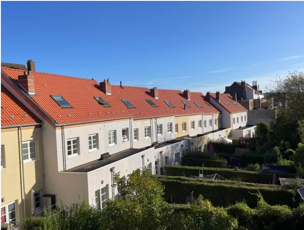
Foto 4 Renovatie huizen Crock-Herdersstaf
