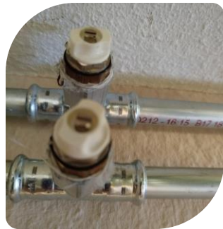
Au niveau des tuyaux dans le hall d'entrée
