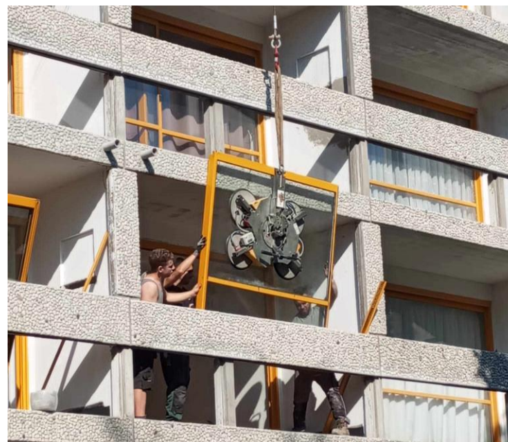
Une ventouse très musclée soulève ce châssis de 450 kilos
