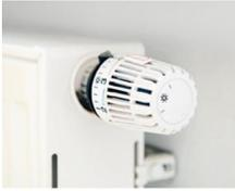
Les vannes thermostatiques régulent pièce par pièce la température souhaitée. Il faut cependant veiller à toujours ouvrir au maximum les vannes des radiateurs présents dans la pièce où est situé le thermostat, afin de ne pas créer de conflits dans le système de régulation d'ambiance thermique.
